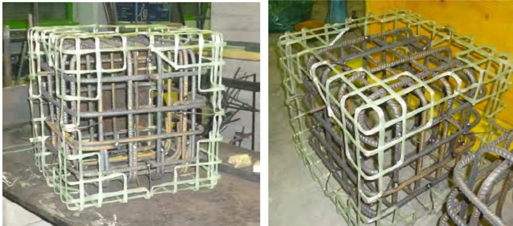
Figura 2. Assemblaggio armatura di pelle;
