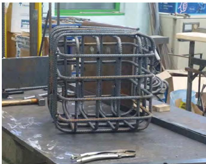
Figura 1. Assemblaggio gabbia metallica
